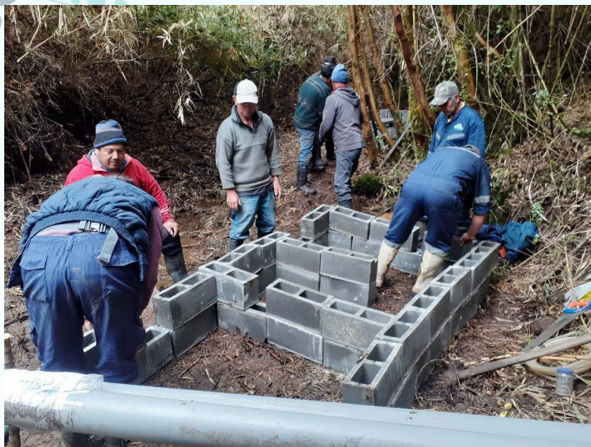
Fig 14. Instalación de la bocatoma. Proyecto RCA Nal Alto, 2023
